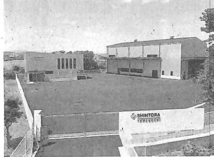
変電機器リサイクルと太陽光パネルリサイクル実証を担う山口工場
